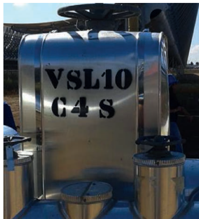
Figura 4.3.2.E. Ejemplo de cajeado metálico desmontable.
