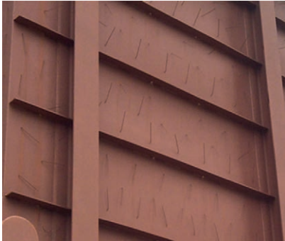
Figura 4.4.1.A. Ejemplo de colocación de pinchos y pernos.
