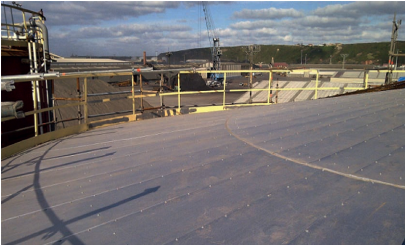
Figura 4.11.9. Ejemplo de aislamiento de techo.
