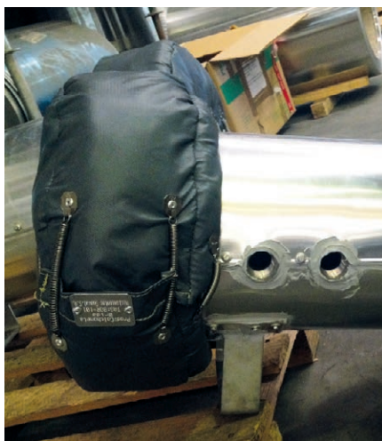
Figura 4.8.1. Ejemplo instalación de colchoneta en brida ciega.
