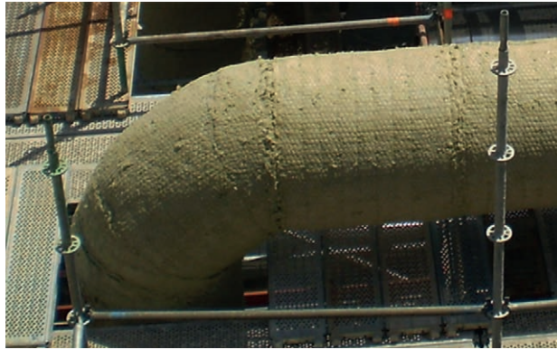
Figura 4.3.2.D. Ejemplo de cosido de manta armada.
