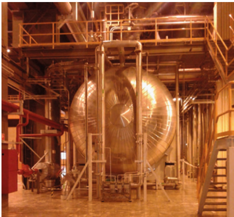
Figura 5.2. Depósito horizontal de acero inoxidable.
