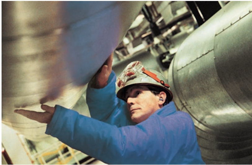
Figura 2.5. Inspección y Mantenimiento en Instalación Industrial Aislada.
