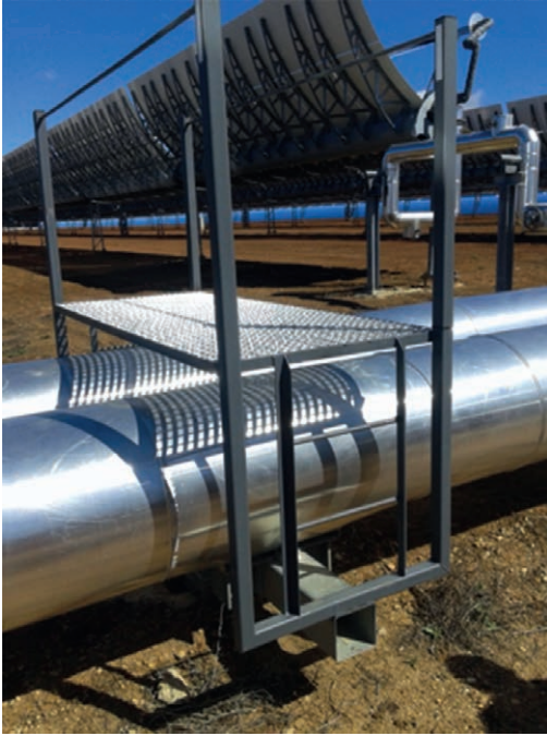
Figura 4.11.12. Ejemplo de plataforma de paso.
