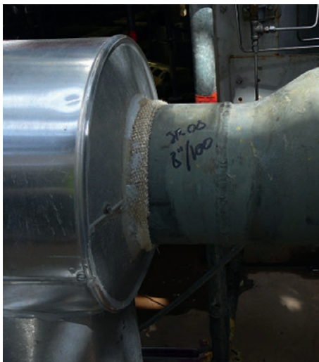
Figura 4.11.10. Ejemplo de ejecución de rotura de puente térmico entre tapa de recubrimiento metálico y tubería para más de 250 °C.
