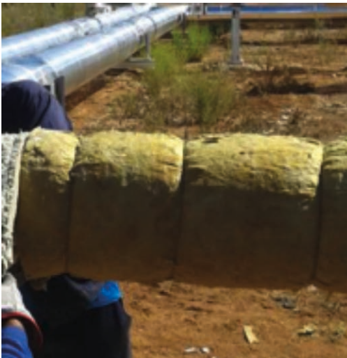
Figura 4.3.2.C. Ejemplo de atado de coquilla con alambre.
