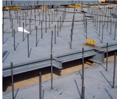
Figura 4.4.1.A. Ejemplo de colocación de pinchos y pernos.
